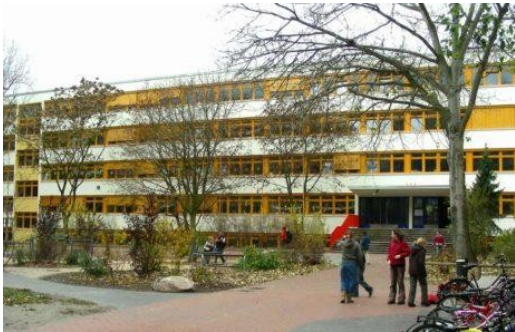
Großer Schulhof Hauptgebäude
